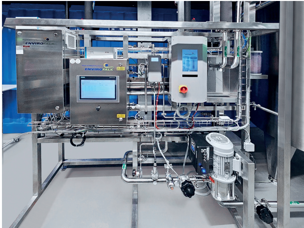
Abbildung 4: Qualitätsüberwachung und Sanitisierungsstrategie: Ozonisierung, Total-Organic-Carbon(TOC)-Messung im PW-, Lager- und Verteilsystem.
