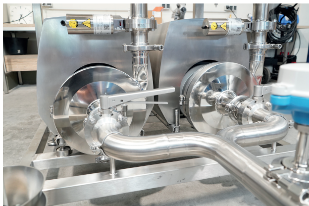
Abbildung 3: WFI-Verteilschleife für pharmazeutische Anwendungen.
